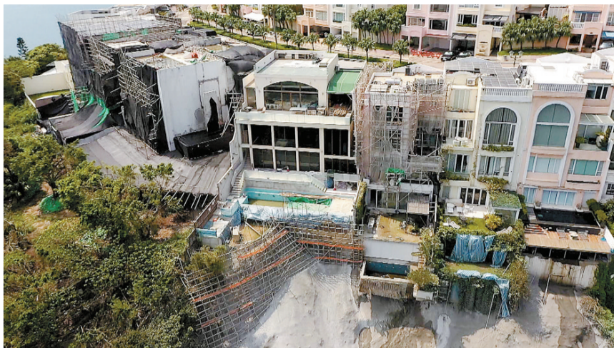
紅山半島有獨立屋業主已聘請工人灌漿鞏固山坡。網上圖片
