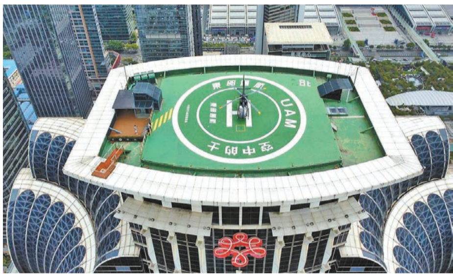
圖為位於深圳福田區的直升機起降場地。官方供圖
