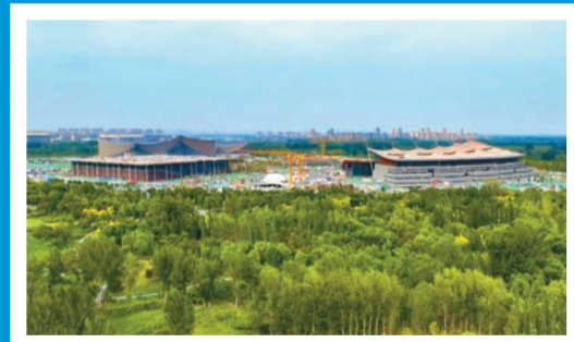
北京城市副中心三大人文建築拔節生長——劇院形似「文化糧倉」，圖書館變身「森林書苑」，博物館猶如「運河之舟」。三大建築作為城市副中心「一軸、兩環、一心」規劃格局的重要組成部分，已於近期竣工，即將試運營。
