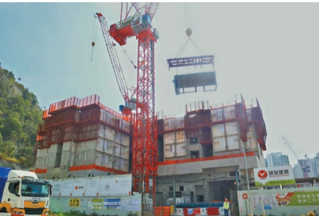
安達臣道公營房屋地盤首用組裝合成建築法。記者 馮瀚文攝
