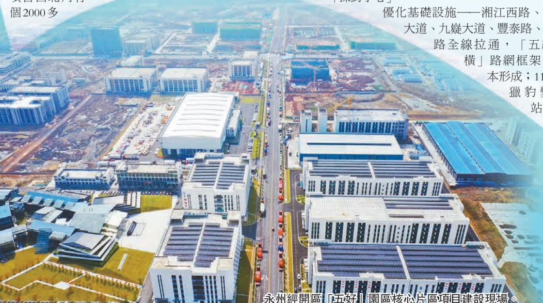
永州經開區「五好」園區核心片區項目建設現場。
