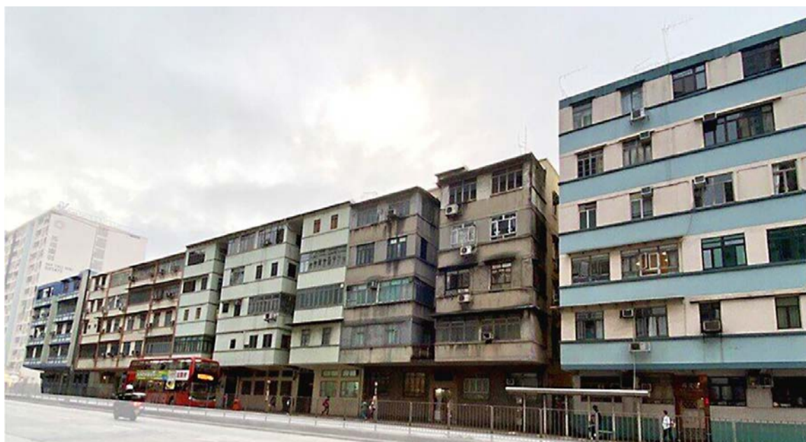
市建局九龍城盛德街/馬頭涌道發展項目原址為公務員建屋合作社地段。
