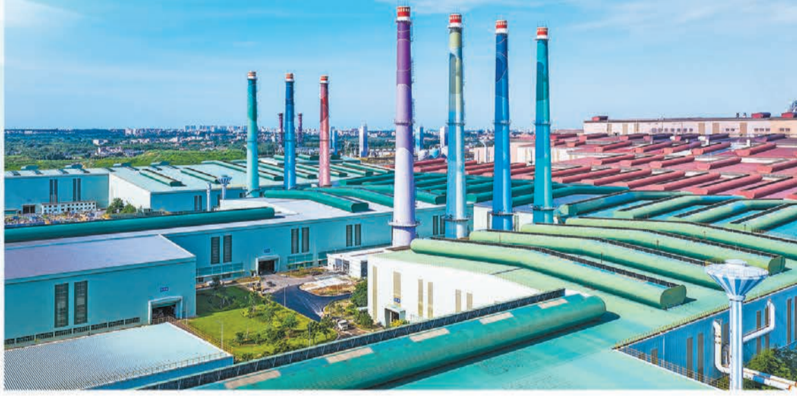
寶鋼湛江鋼鐵有限公司
