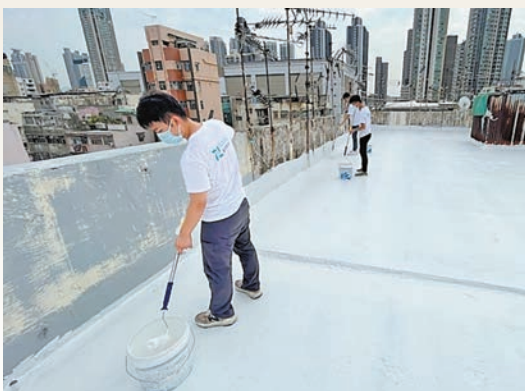
在建築物屋頂塗上「無電製冷技術」塗料，表面溫度可降30℃。
