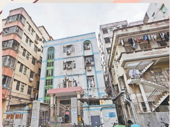
南園小學舊址，白色居民樓牆上仍隱約可見 「南園小學」校標脫落後留下的痕跡。
