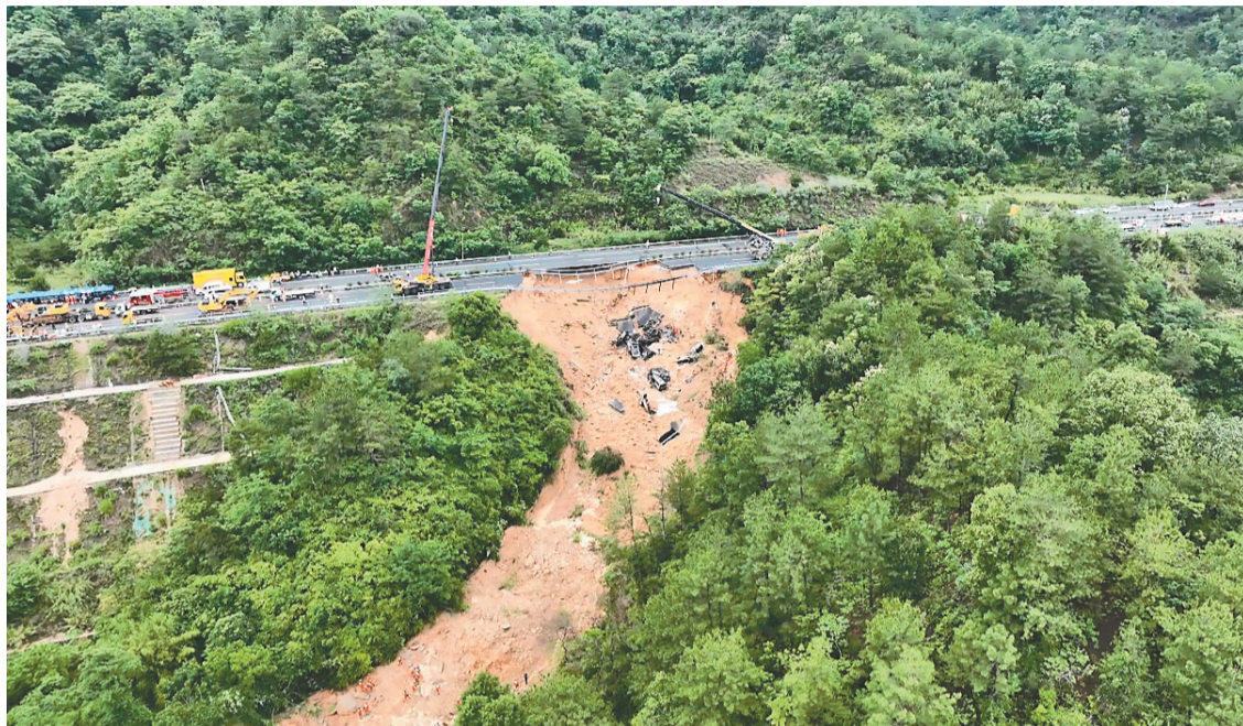
廣東梅大高速路面塌方事故現場。 新華社
