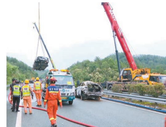
救援力量在塌方事故現場開展緊急救援。 新華社
