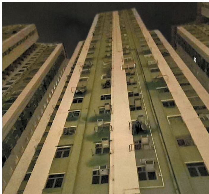
昨日凌晨2時許，荃灣荃威花園3座大廈電表總掣跳掣，於凌晨5時許重啓恢復電力。
