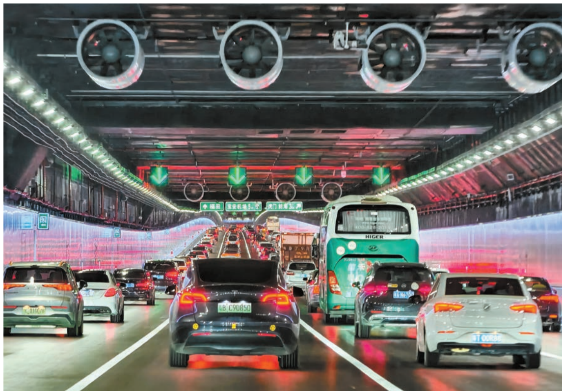
深中通道開通首日海底沉管隧道內的車流。 新華社
