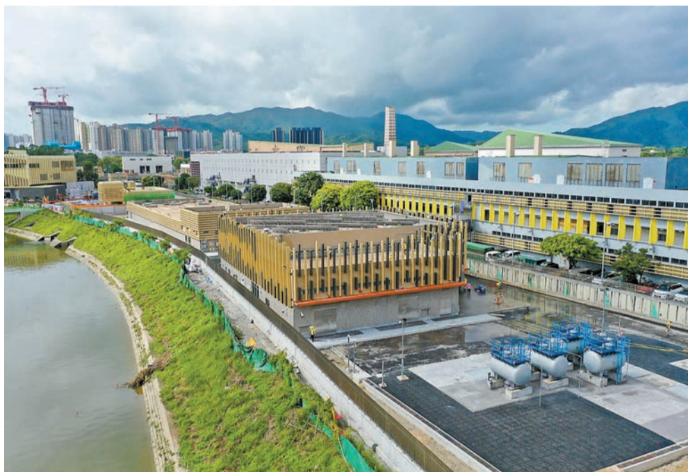
▶藉着石湖墟污水處理廠重建工程的契機，水務署在石湖墟興建再造水廠，為部分經石湖墟污水處理廠三級處理後的排放水加入次氯酸鈉，作進一步處理，生產再造水。圖為石湖墟發展局
