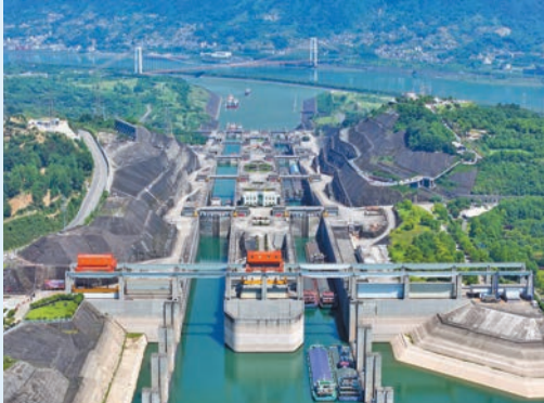
湖北省宜昌市三峽雙線五級船閘俯瞰圖。（新華社圖片）
