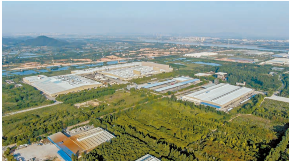
鋁遊家大灣區生產基地，佔地面積約6.5平方公里，具備鋁材、鋼結構、混凝土等一站式供應鏈。
