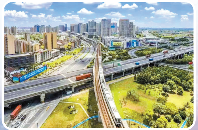
上海軌交11號線昆山花橋段。
