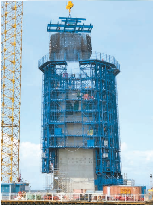
深中大橋超高混凝土橋塔鋼筋部品柔性製造與快速吊裝。
