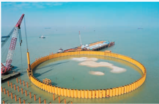
2018年11月29日，深中通道大橋東錨碇築島圍堰成功合龍。 張政 攝
