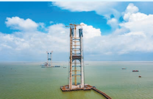
2021年6月17日，中交二航局承建的深中大橋東索塔封頂，圖為大橋施工整體景象。 張政 攝
