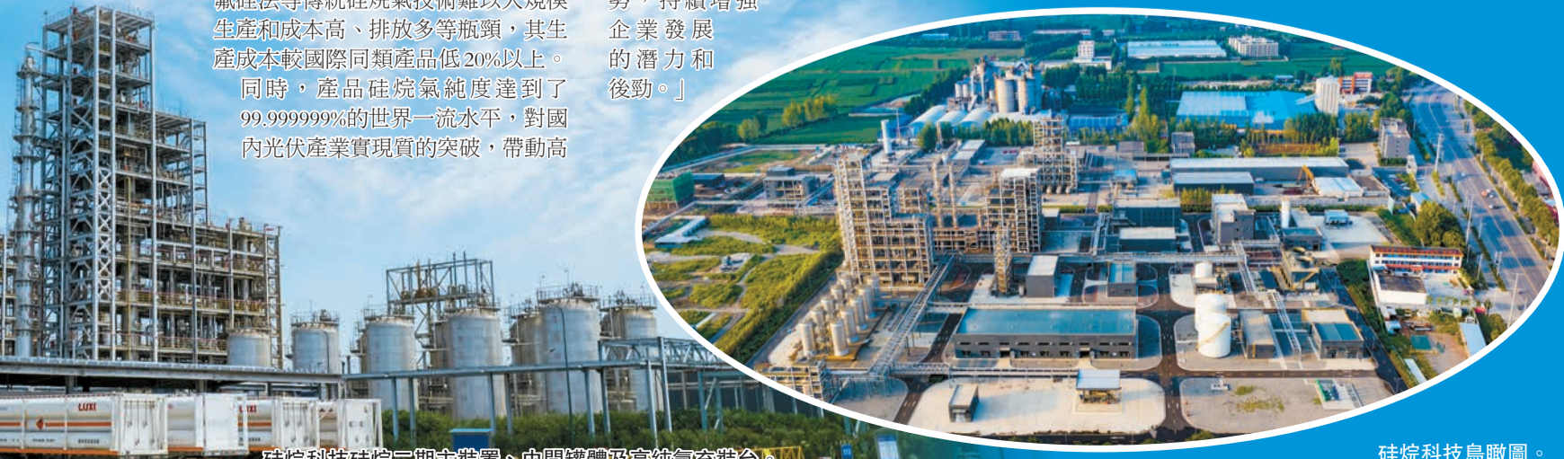
硅烷科技硅烷二期主裝置、中間罐體及高純氫充裝台。
