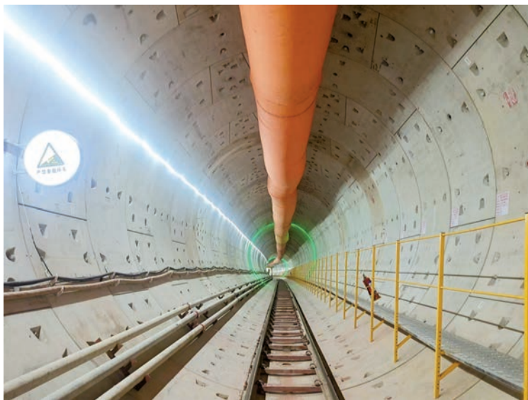
12號線景雲路區間隧道。廣州地鐵供圖
