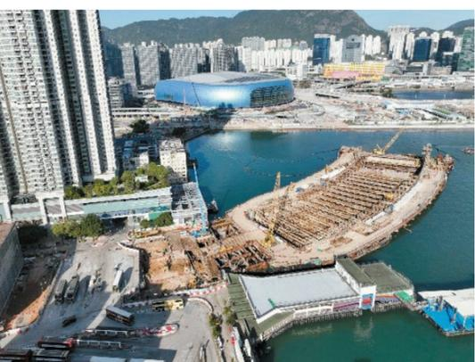
早前建造海底隧道的臨時圍堰及橫向支撐系統。運輸及物流局供圖
