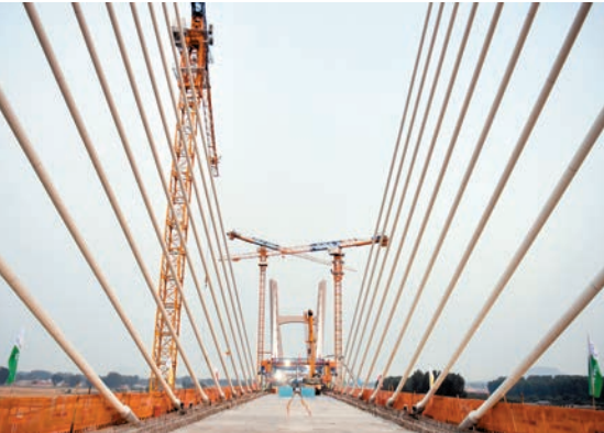
雄忻高鐵站前二標項目施工建設有序進行。
