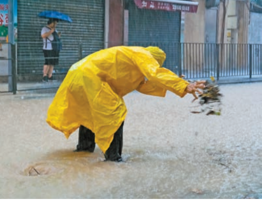
香港南區一條道路出現水浸，清潔工人冒雨清理堵塞的渠道。
