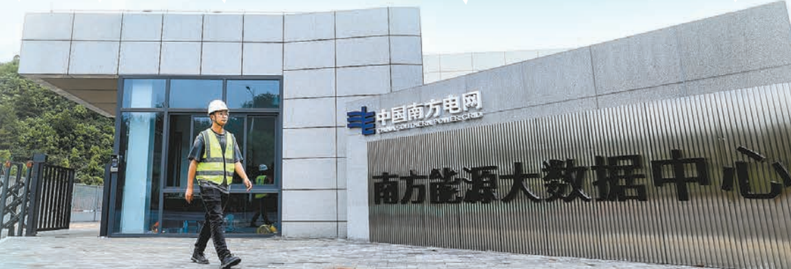
南方能源大數據中心（一期）已於近日通過竣工驗收，目前安裝好的500個機櫃已全部上架試運營。石照昌攝
