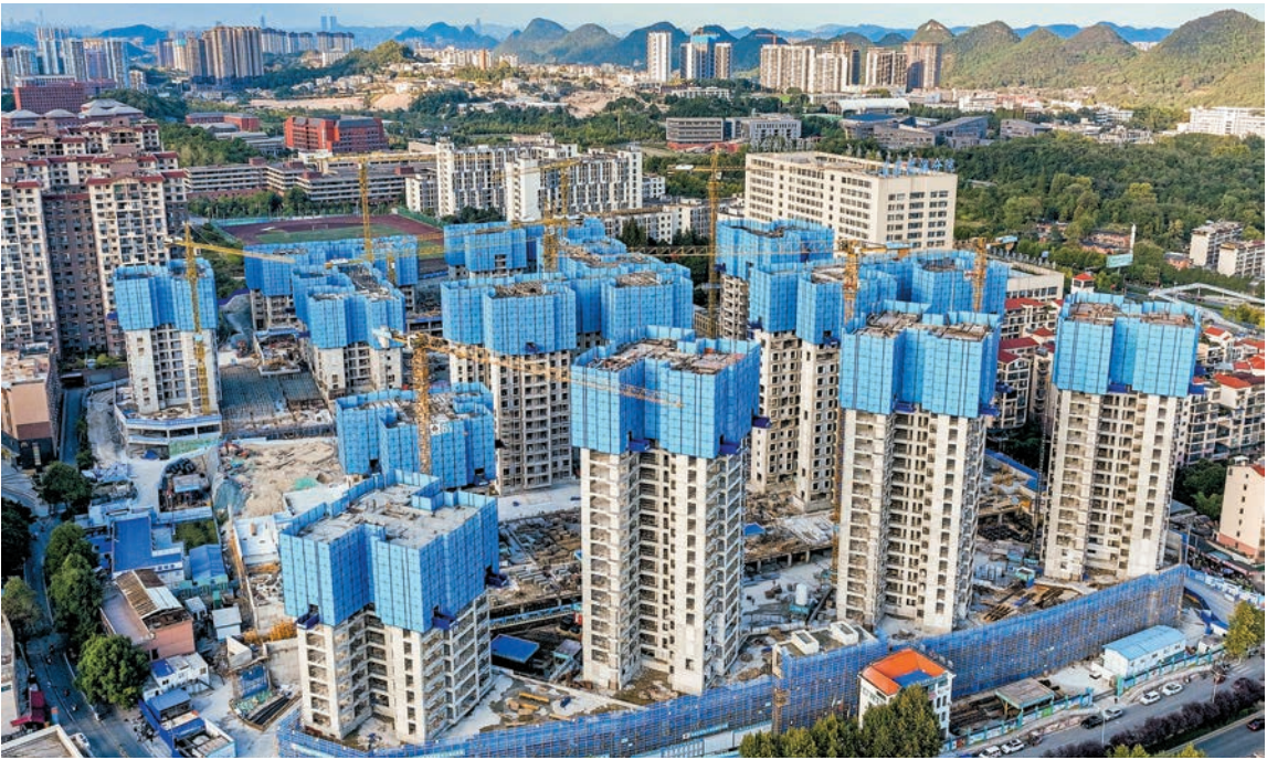
圖為航拍貴州省貴陽市花溪區一處在建樓盤。 中新社
