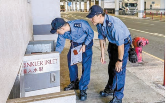
消防處人員巡查大廈及建築物消防設施。
