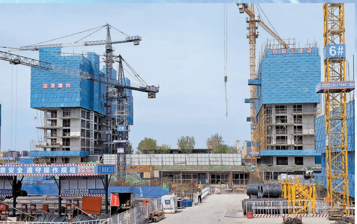
南關區的各大重點工程現場，塔吊林立、機器轟鳴。
