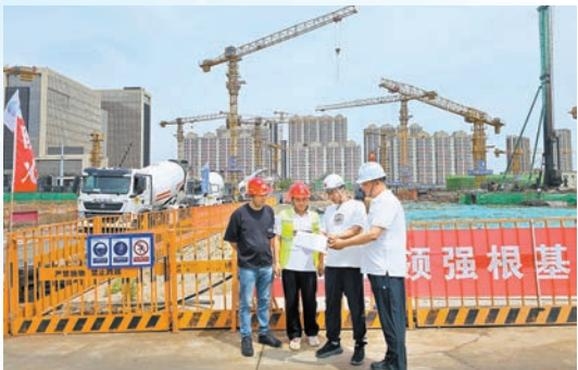
建設者們正搶抓施工黃金期。
