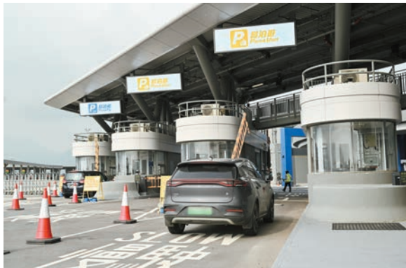
旅客可自駕車輛經港珠澳大橋前往由機管局營運、位於香港口岸人工島的自動泊車系統。機管局圖片
