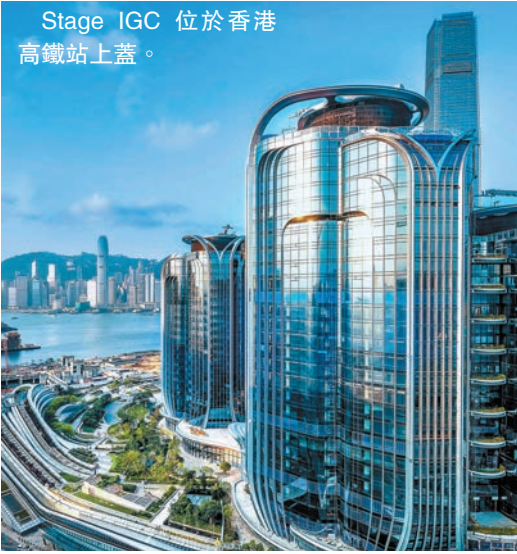
Stage IGC 位於香港高鐵站上蓋。
