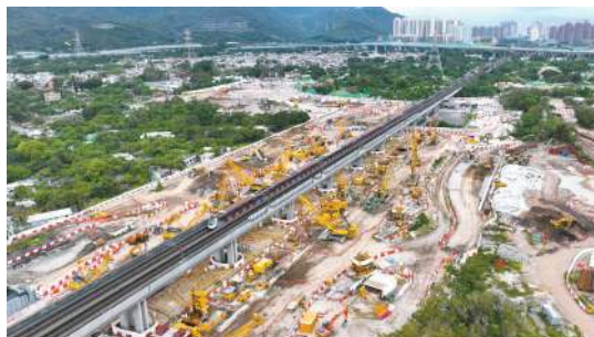
屯馬綫洪水橋站工地。港鐵相片
