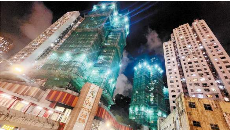
廉署、警方與競委會上星期採取代號「鐵盟」三方聯合行動，打擊樓宇維修貪污圍標集團，行動中合共拘50人，包括集團主腦及骨幹成員。圖為牛頭角安基苑正進行大廈維修工程。
