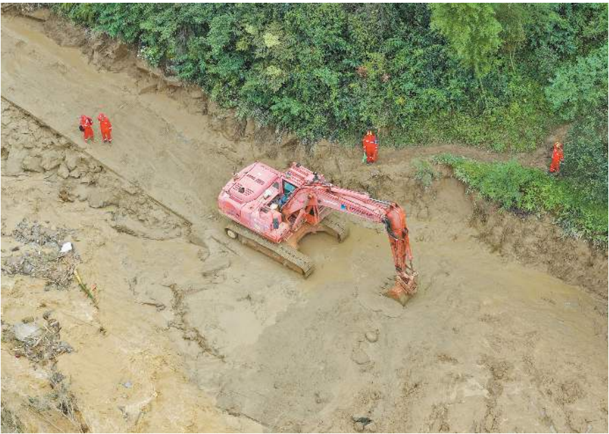
中國安能救援力量在遂川縣泥石流現場開展道路搶通作業，大型工程機械對核心區域損毀路段、泥石流淤積區域進行清障疏通。 中新社
